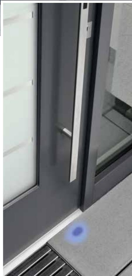
Pokretom stopala preko svjetlosne točke vrata se mogu otvoriti - komforno i beskontaktno.
