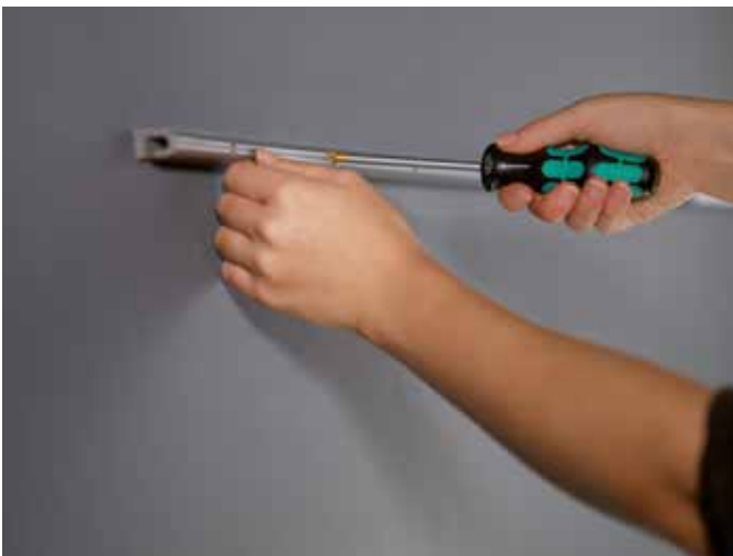
1. Pričvrstiti vodilicu na zid
