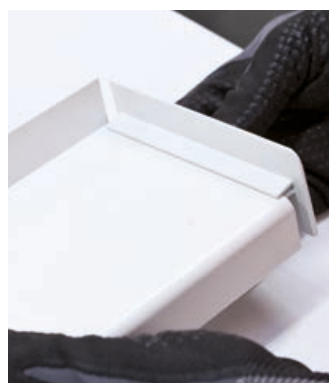
Montaža bočnih aluminjskih završetaka
